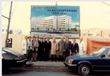
Начало строительных работ центра охраны здоровья матери и ребенка и
